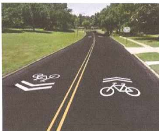
Fig. 17 Semnalizarea pistei de biciclete (pe banda cu trafic general)
