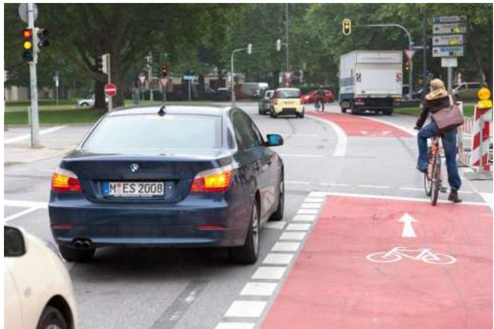
**Figura 9.4.6 Realizarea pistelor pentru biciclete in locul unei benzi de circulatie rutiera, Munchen - Germania**
